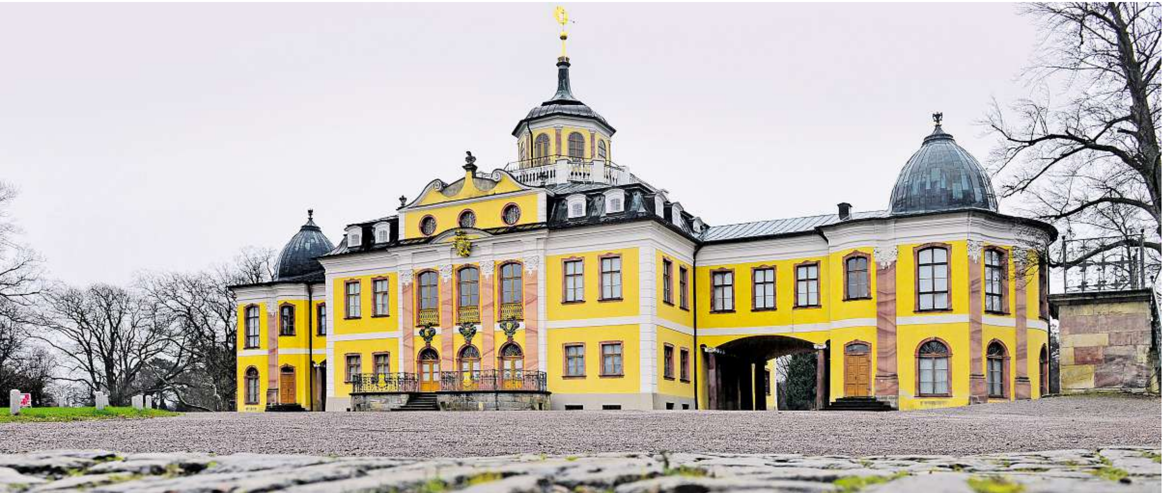
Schloss Belvedere spiegelt sich auf den regennassen Steinen. Während das Schloss im Winter geschlossen bleibt, kann man in der Orangerie das um 1870 zum Wintergarten umgebaute Pflanzenhaus besichtigen
